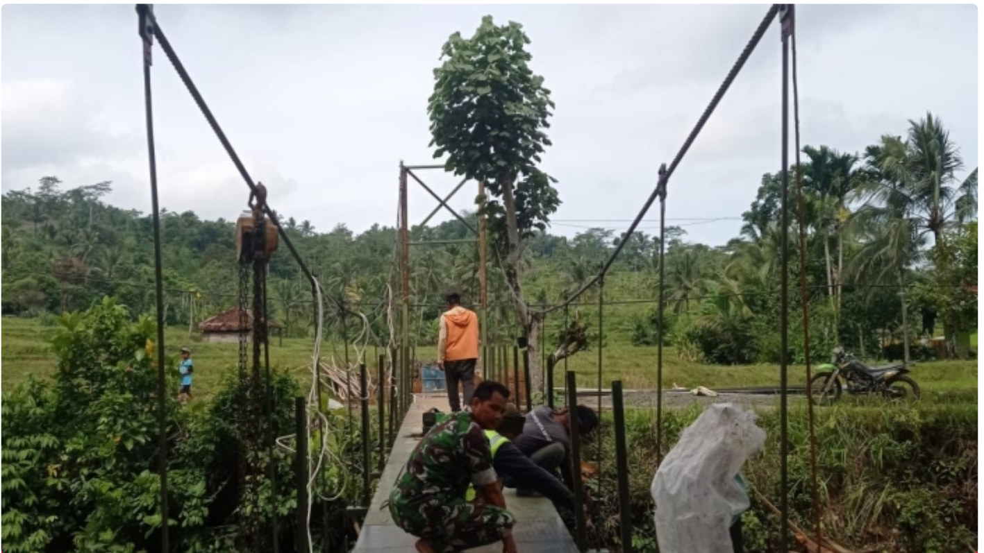
Kpt Arm Witono: Pengerjaan Jembatan Gantung Sudah 80%
